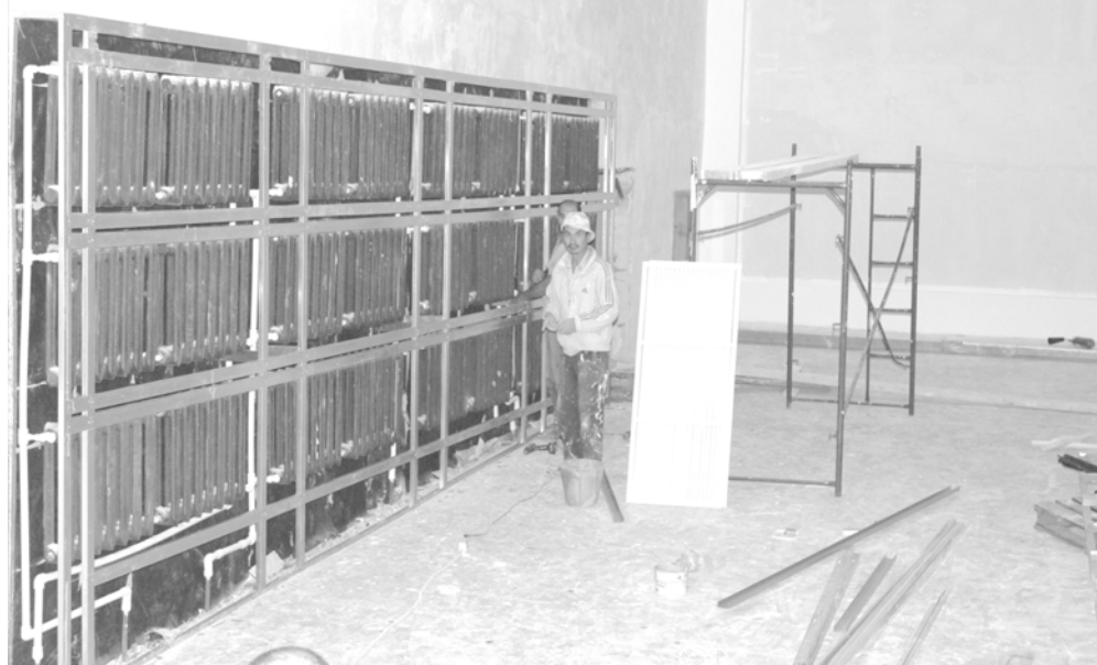
Ремонт зрительного зала районного Дома культуры
